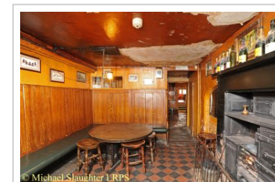
Sliding Door Room
